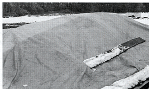
写真1 PEシートで上部から被覆
